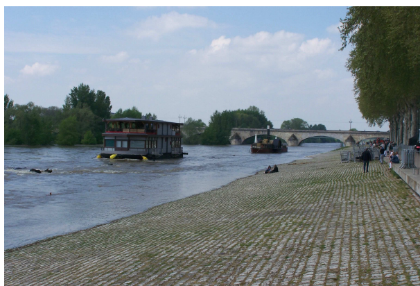
Au niveau du quai d'Orléans
