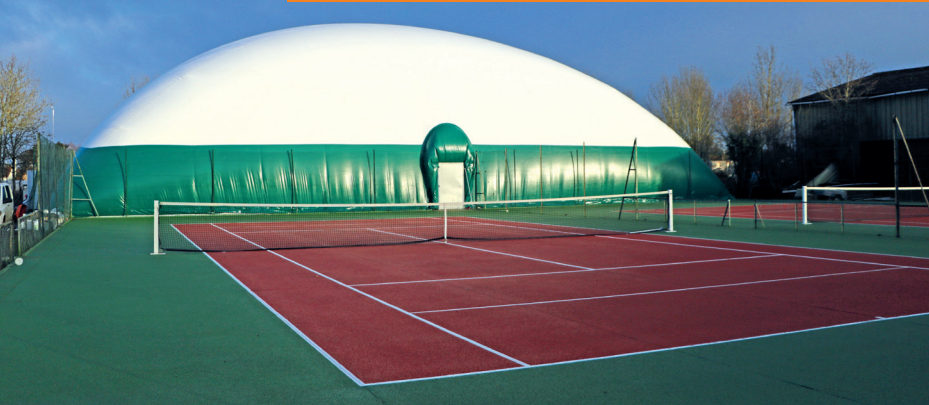
DÉCEMBRE • Installation de la bulle autour du terrain de tennis
